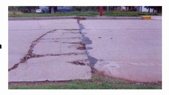
Se establecen metodologías para evaluar la presencia de minerales reactivos y la expansión potencial en el hormigón.
