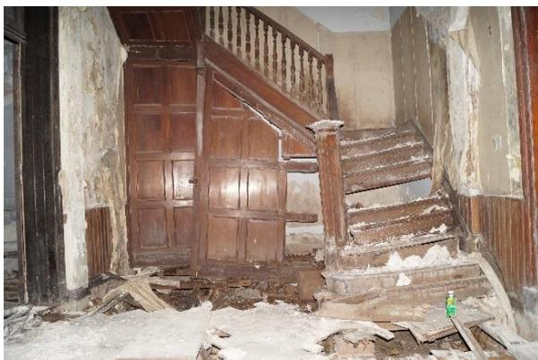
En el interior de la casa se observa la existencia de dos escaleras de madera (principal y secundaria) de acceso a la segunda planta, y una tercera de material que desciende al sótano. La escalera principal, de gran valor por su diseño y construcción, se encuentra inutilizada ya que se ha desplazado, encontrándose próxima a su colapso.
